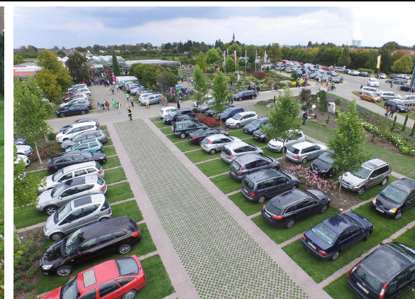
Přístupová komunikace a parkovací stání s polopropustným povrchem
